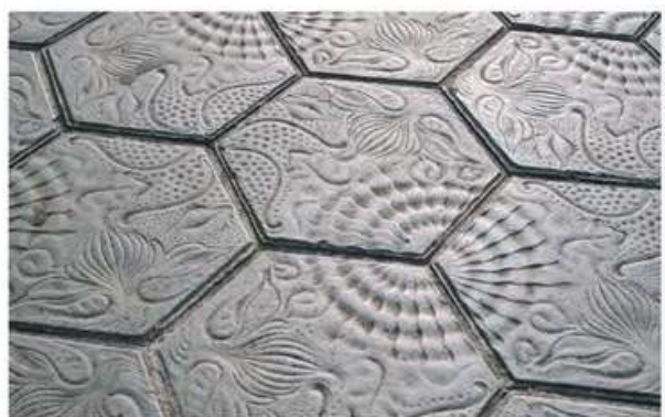
Ladrilhamento de calçada
