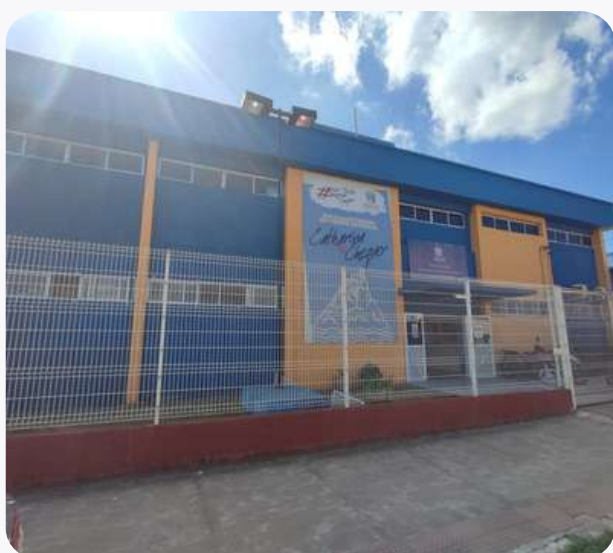
Identificação da fachada da EEEFM Catharina Chequer, Vila Velha, ES.
