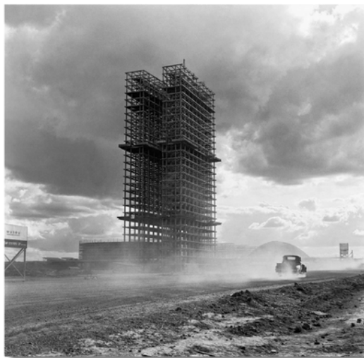
Palácio do Congresso Nacional em construção, Brasília, c. 1958. Marcel Gautherot / Acervo IMS*
