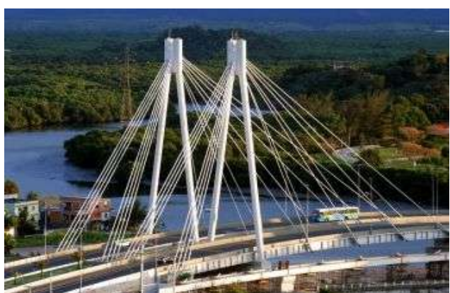
Ponte da Passagem - Vitória/ES
