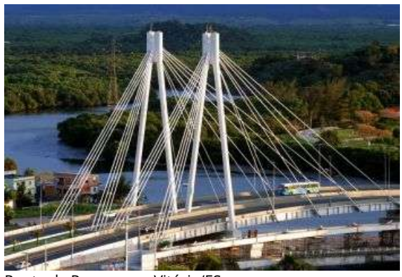
Ponte da Passagem - Vitória/ES Autor: Elizabeth Nader. Disponível: https://www.vitoria.es.gov.br/semc/monumentos-culturais#a_pontedapassagem . Acesso em 30/04/2025.
