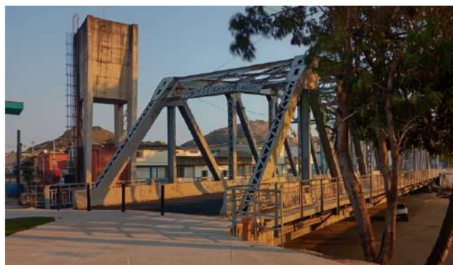
Ponte Florentino Avidos (Ponte Seca)
