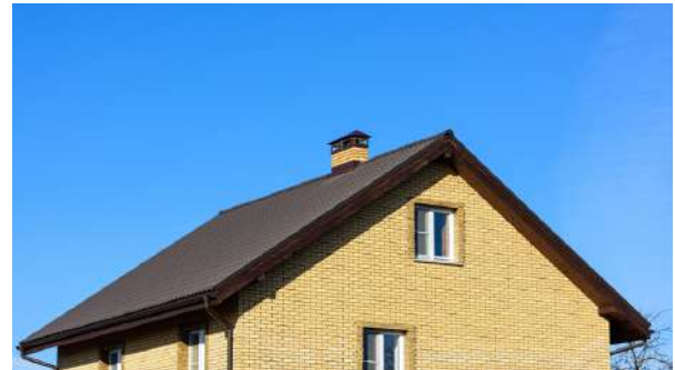
Telhado de duas águas
